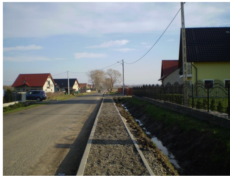
Chodnik w trakcie realizacji.
