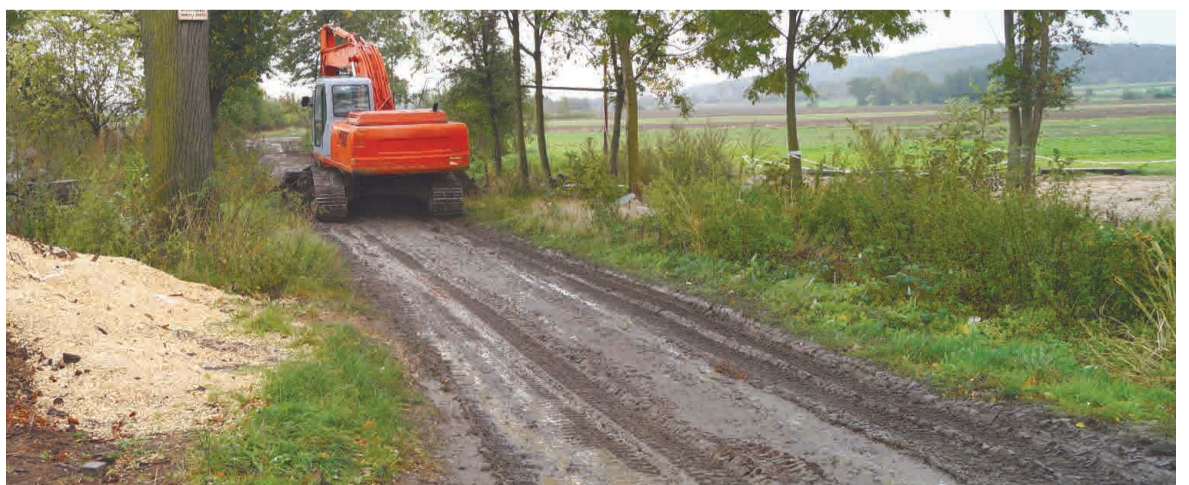
Rozpoczęły się prace przebudowy blisko kilometra drogi gminnej w Chełmcu.
