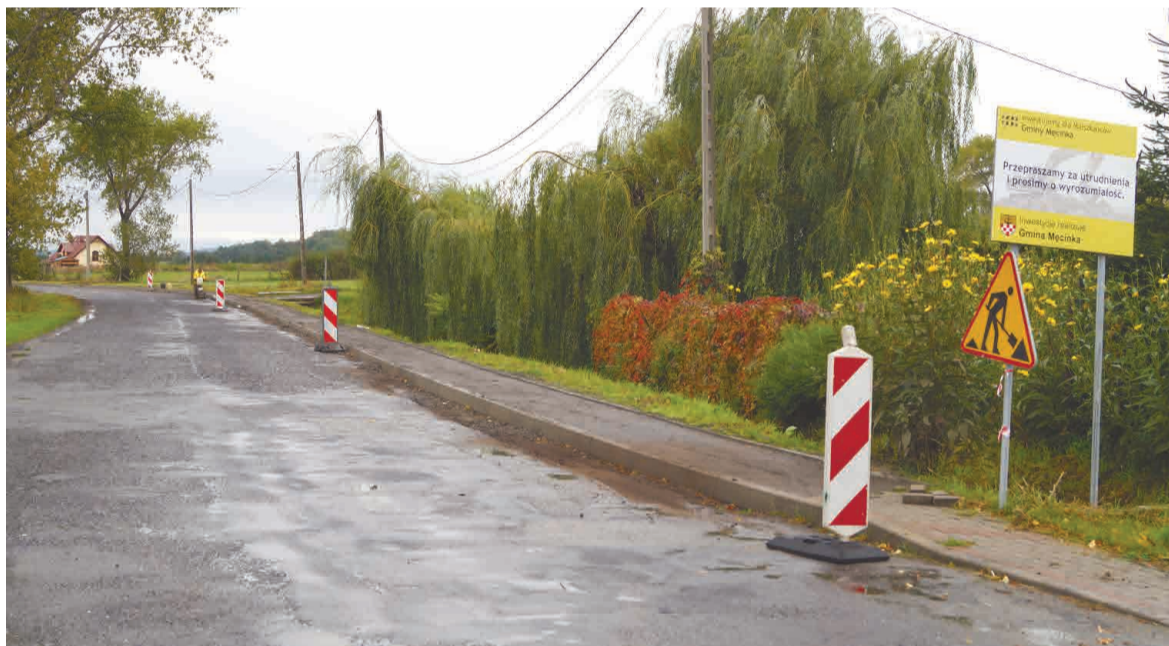
Budowa prawie dwukilometrowego chodnika w Nowej Męcince.
