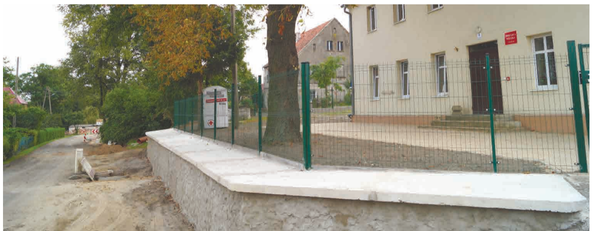
Wykonano remont muru oporowego przy świetlicy wiejskiej w Sichowie.
