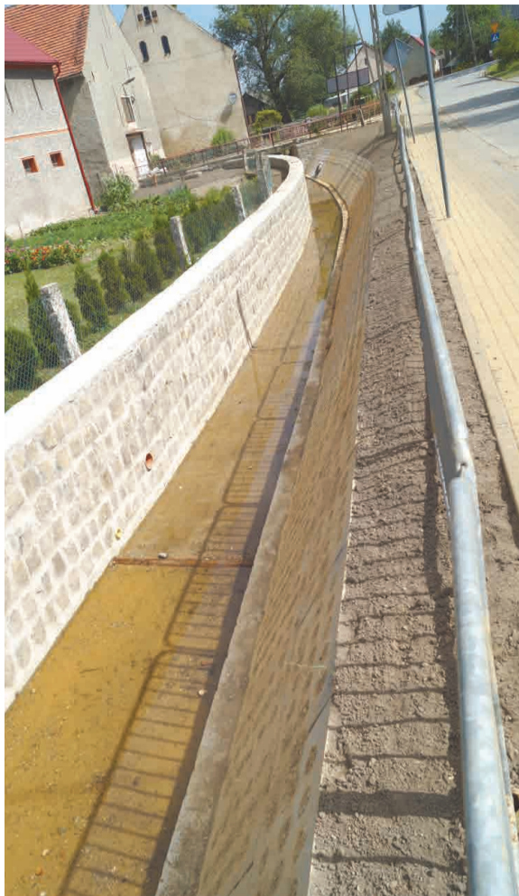
Wykonano umocnienie skarp rowu w Chroślicach.
