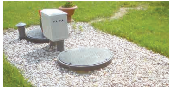
Realizacja przydomowych oczyszczalni ścieków w Muchowie, Pomocnem, Kondratowie i Stanisławowie.
