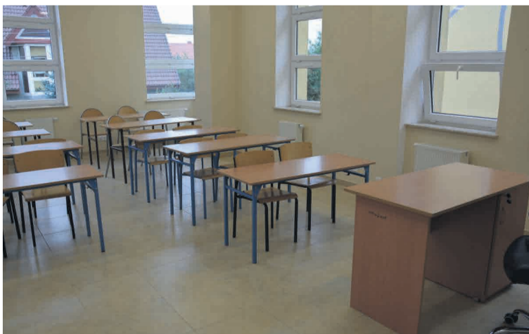
Przed rozpoczęciem roku szkolnego trwały intensywne prace remontowe w dwóch szkołach gminy Męcinka w celu polepszenia warunków nauczania. Dzięki środkom z budżetu Gminy Męcinka w Zespole Szkolno-Przedszkolnym w Piotrowicach dokonano następujących remontów, m.in. przebudowano pokój nauczycielski na parterze po prawej stronie, przygotowano w nim nowy gabinet dyrektora i sekretariat. Z ówczesnego gabinetu dyrektora zrobiono nową salę lekcyjną do nauki chemii. Portiernia natomiast przekształcona została na pokój nauczycielski, a na drugim piętrze powstał nowy pokój dla pedagoga. Przebudowano także toalety. W Zespole Szkół w Męcince dokonano całkowitej przebudowy i remontu pryszniców oraz toalet przy sali gimnastycznej.
