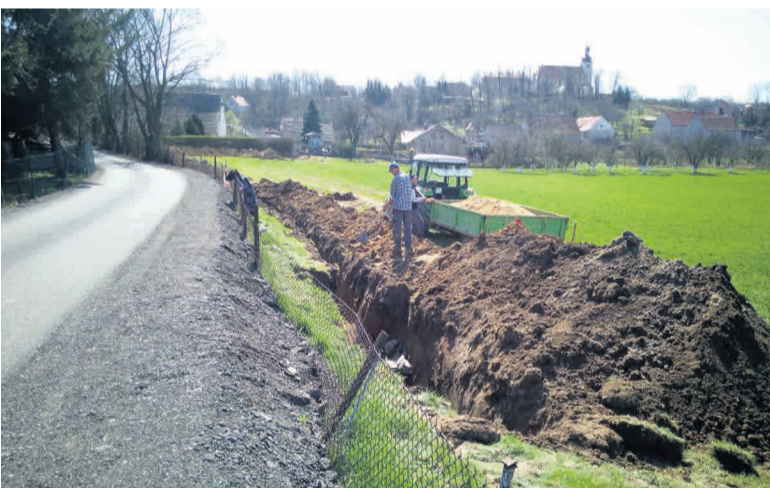
Zmodernizowano 250 m sieci wodociągowej w Słupie w celu poprawy świadczenia przez Gminę Męcinka usług związanych z dostarczeniem wody mieszkańcom tego sołectwa.
