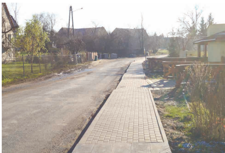
Budowa chodnika przy drodze powiatowej w Piotrowicach.
