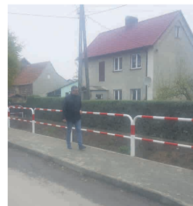
Zamontowano barierki ochronne w Maluszowie w celu poprawy bezpieczeństwa.
