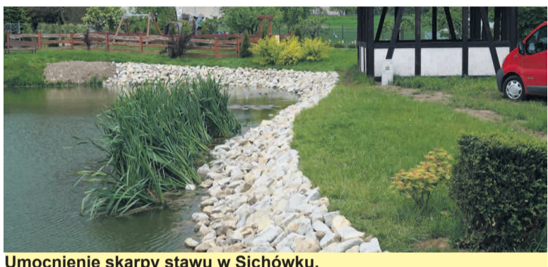
Umocnienie skarpy stawu w Sichówku.
