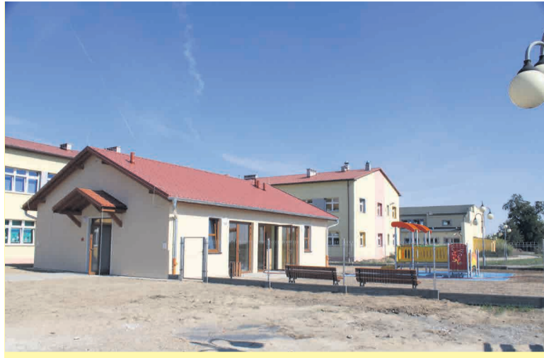
Budowa żłobka w Męcince. Inwestycję zrealizowano dzięki pozyskanej dotacji z budżetu państwa oraz dotacji unijnej.
