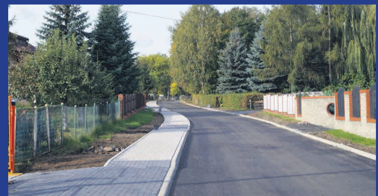
Budowa blisko dwukilometrowej drogi, chodnika i kanalizacji deszczowej w Sichowie. Inwestycja zrealizowana dzięki pozyskanej dotacji unijnej oraz w ramach budżetu gminy.
