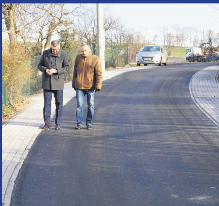
Budowa drogi gminnej wraz ciągami pieszymi w Słupie. Inwestycja zrealizowana dzięki pozyskanej dotacji z budżetu państwa oraz w ramach budżetu gminy.
