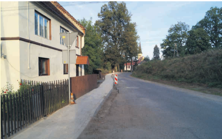
Budowa chodnika w Kondratowie. Inwestycja zrealizowana została w ramach współpracy Gminy Męcinka i Powiatu Jaworskiego.
