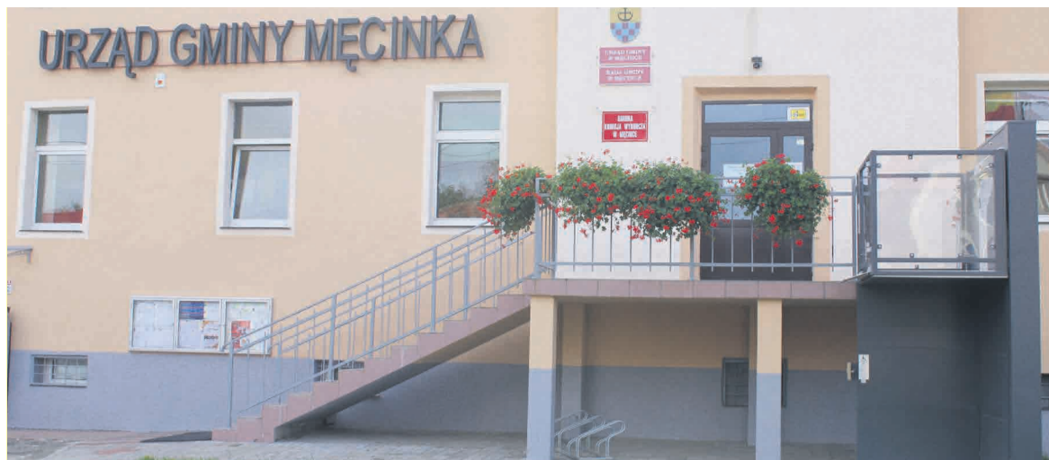
Montaż windy dla niepełnosprawnych przy Urzędzie Gminy w Męcince zapewnił poprawę dostępności do obiektu.
