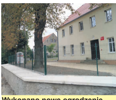
Wykonano nowe ogrodzenie i remont muru przy świetlicy wiejskiej w Sichowie.
