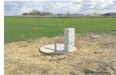
Budowa kanalizacji do gminnych terenów inwestycyjnych w Nowej Męcince.
