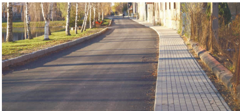
Przebudowana droga wraz z nowym chodnikiem w Maluszowie.
