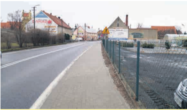
Chodnik przy drodze krajowej w Maluszowie. Inwestycja zrealizowana dzięki współpracy z GDDKiA.
