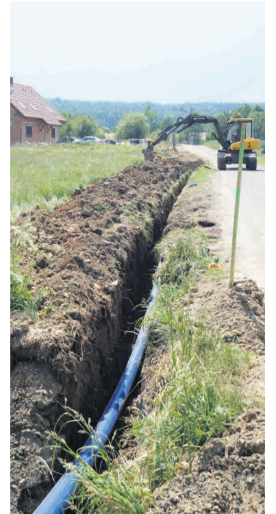
Budowa wodociągu w Myślinowie wykonana została w ramach dotacji unijnej.
