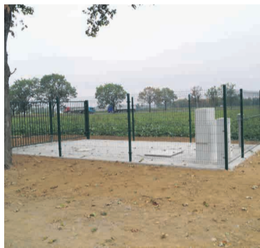
Budowa sieci wodociągowej i kanalizacyjnej na Osiedlu w Piotrowicach.
