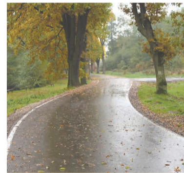
Odbudowana droga Bogaczów – Pomocne poprawiła dostęp do wielu instytucji użyteczności publicznej mieszkańcom górskich terenów naszej gminy.
