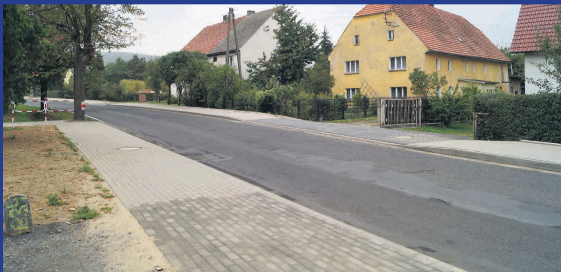
Budowa chodnika w Chelmcu. Inwestycję zrealizowano dzięki pozyskanej dotacji z DSDiK.
