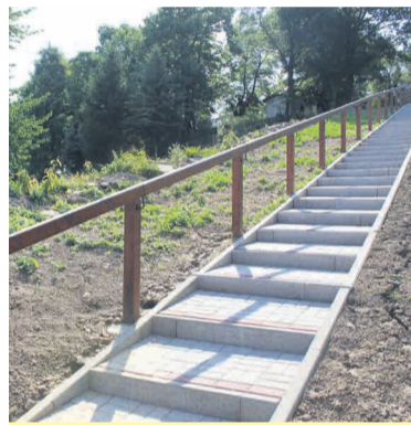
Budowa chodnika w kierunku kościoła w Słupie.
