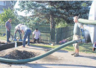
Modernizacja sieci wodociągowej do terenów inwestycyjnych w Nowej Męcince.
