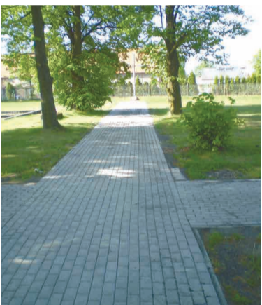
W celu poprawy warunków korzystania z cmentarzy komunalnych wykonano utwardzone alejki w Sichowie i Małuszowie.
