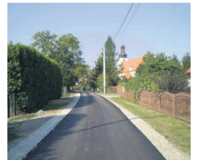
Budowa drogi gminnej w Słupie poprawiła bezpieczeństwo i standard życia mieszkańców. Inwestycja została zrealizowana dzięki pozyskanej dotacji z budżetu państwa.
