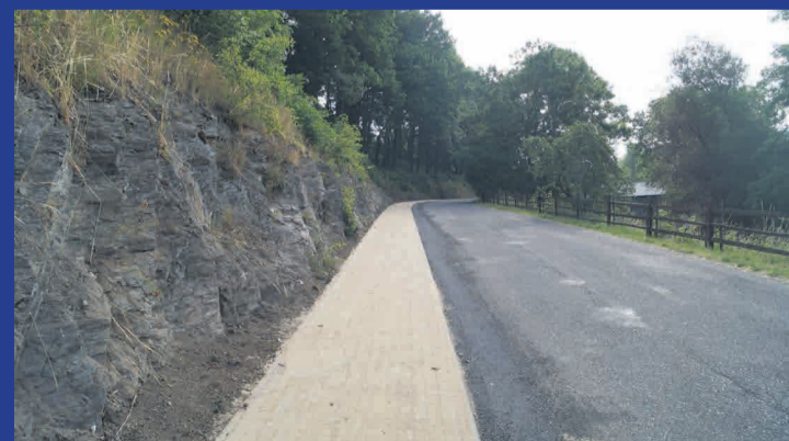
Budowa chodnika w centrum Pomocnem łączącego najważniejsze miejsca aktywności społecznej i kulturowej: świetlicę wiejską, kościół, ośrodek zdrowia, przedszkole, punkt biblioteczny. Inwestycja zrealizowana w ramach budżetu gminy. Trwają prace przygotowawcze związane z rozbudową chodnika w tej wsi.
