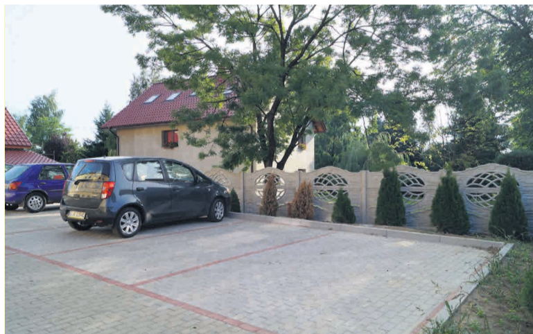
Budowa miejsc parkingowych przy ośrodku zdrowia i GOPS w Męcince.
